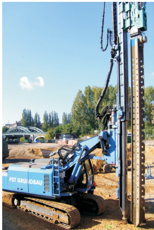
▲ Tiefenverdichtung
