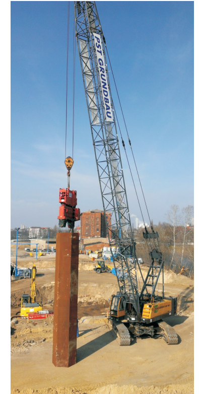
Seilbagger mit 9 m-Wabe
