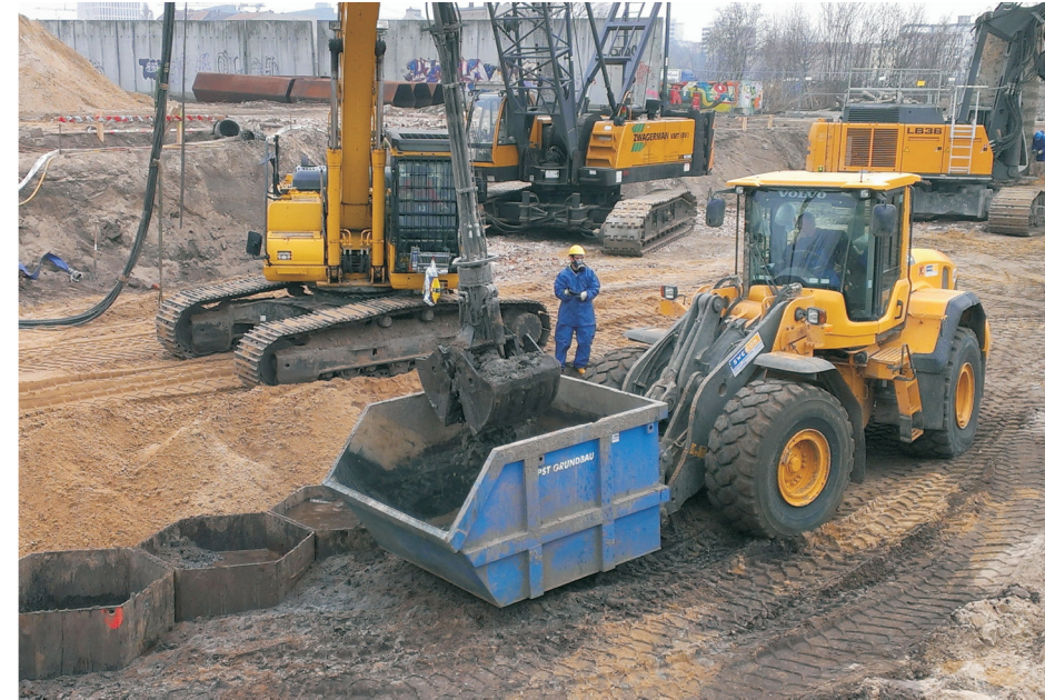
Befüllung Bohrgutbox mit Wabenaushub
